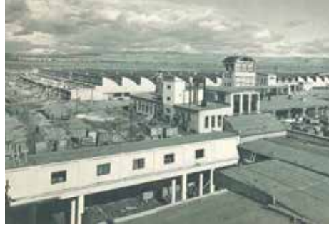
Kayseri Sümerbank bez fabrikası.
